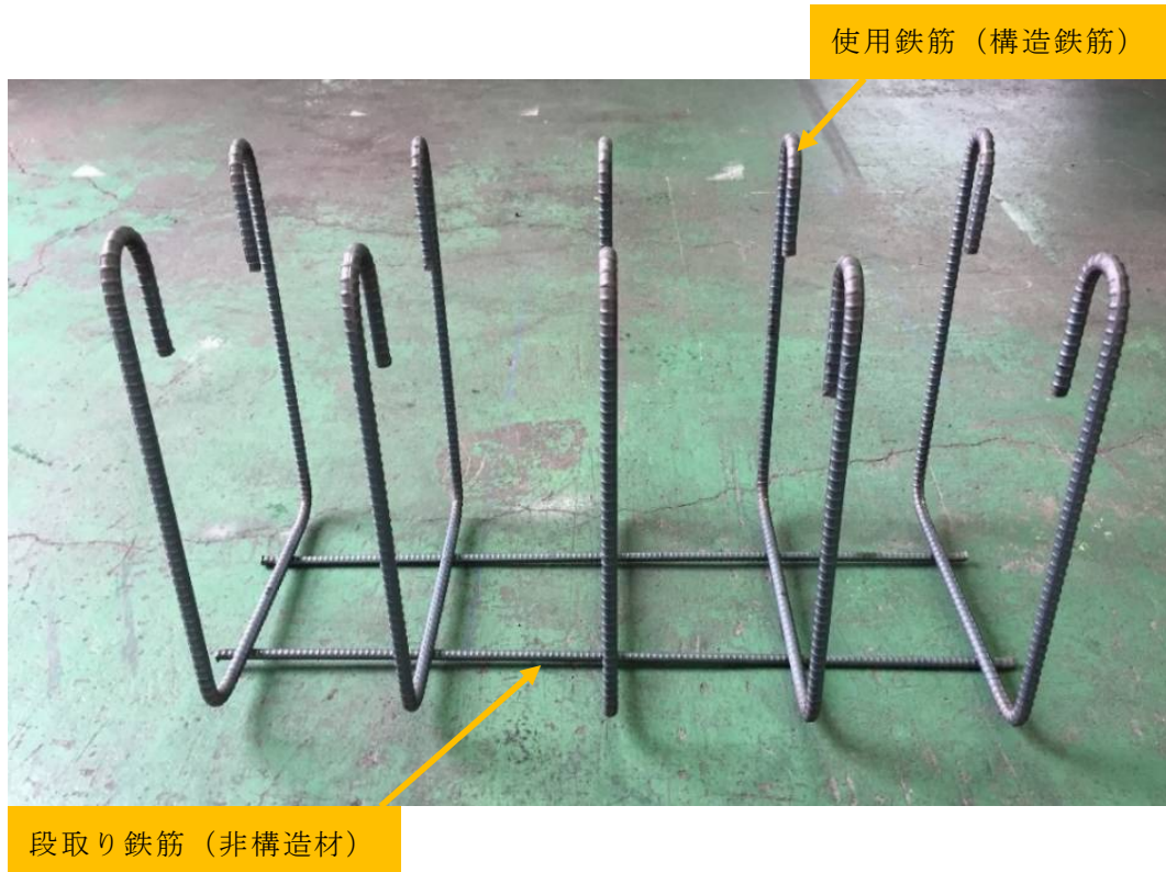
図 1 鉄筋ユニット参考図
